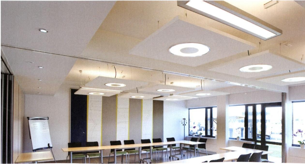
L'acoustique de cette vaste salle de réunion est maîtrisée grâce à un traitement du mur et par des panneaux flottants de 1,2 m par 1,2 m. Ceux-ci sont suspendus d'environ 40 cm et espacés de plus de 50 cm, de sorte que la perte d'effet direct estimée par rapport à une configuration de béton nu est estimée à 15-20 %.
