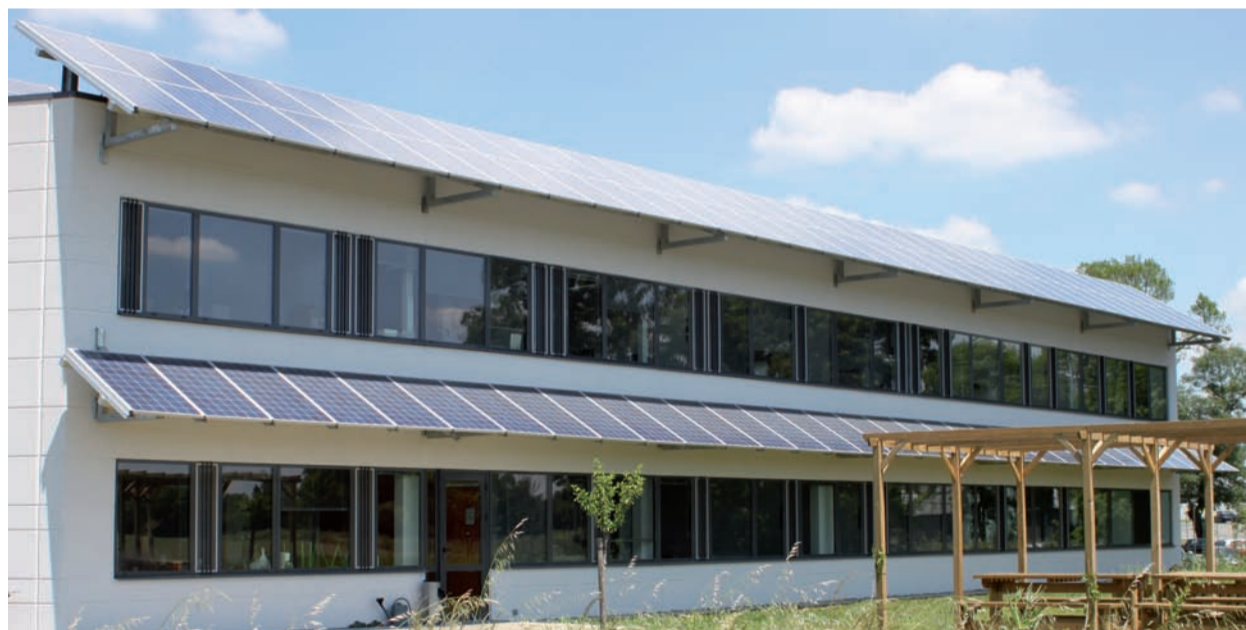
La température souterraine constante de 19° est captée par une pompe à chaleur reliée à 8 forages de 100 m chacun et diffusée dans les planchers flottants.
