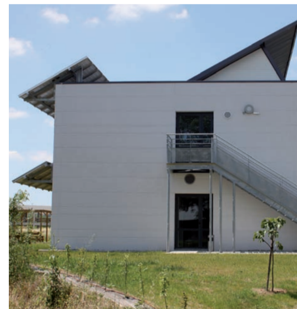
355 m 2 de photovoltaïque supportés par des sheds en toiture et par les brise-soleil en façade.
